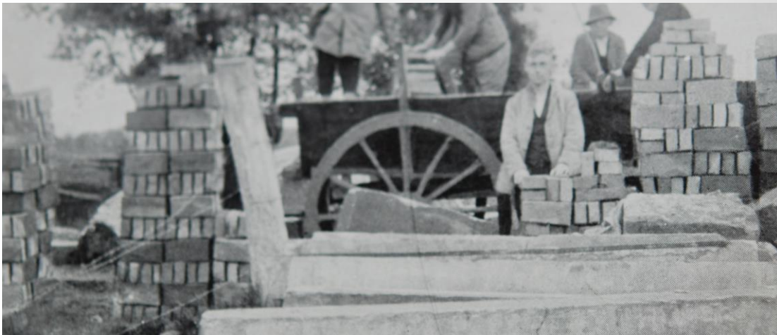
Bau der Wasserleitung.
