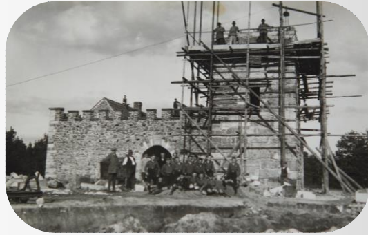
Mauerarbeiten am Turm
