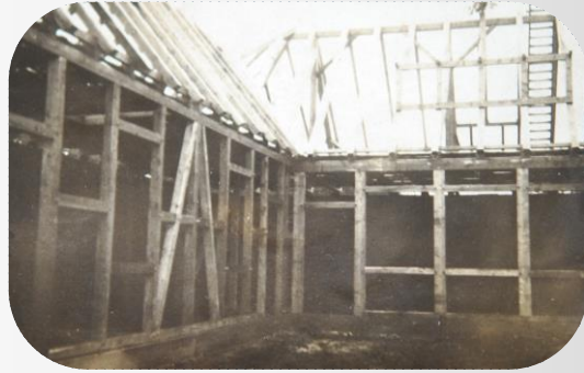
Fachwerk und Dachstuhl.
