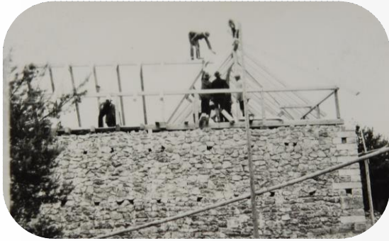
Der Dachstuhl wird aufgebaut
