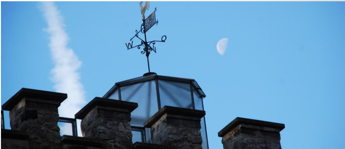
Wetterdach über den Turmaufgang.
