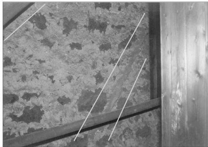
Ansicht von der Ostwand des Turmes auf dem Boden des jetzigen Kirchenschiffes. Die senkrechten Bretter rechts sind Verkleidungen der Orgeleinrichtung. Zwischen den Linien verläuft der frühere Dachansatz des Kirchenschiffes vor 1767, links oben ist ein Sparren des heutigen Kirchendaches zu erkennen. Foto: Stefan Kobelt
