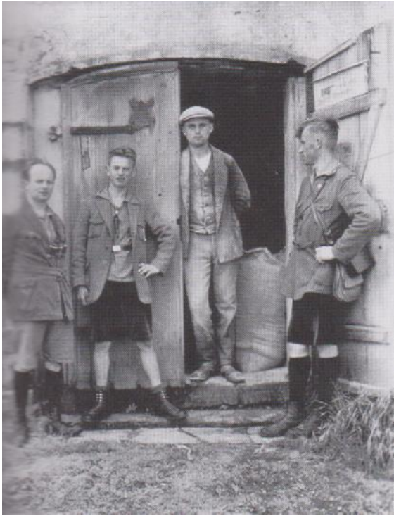
Heinrich Pries 1932 mit Helfern am Eingang der Mühle.
