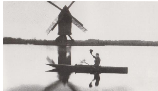
Stauteich an der Viehbruchsmühle mit der Bockwindmühle auf der Dammkrone.
