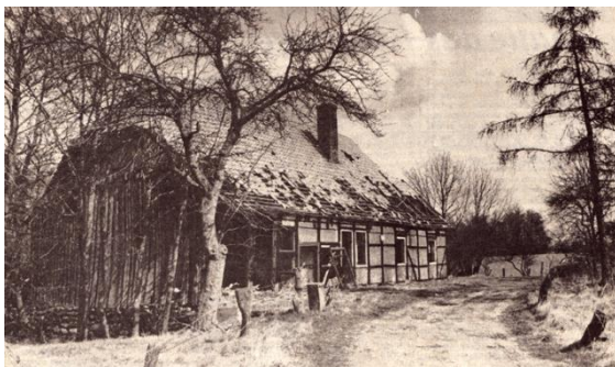
Der Verfall ist nicht mehr aufzuhalten (Aufnahme von 1977).
