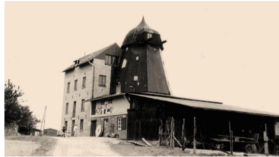
Die Mühle 1955 mit dem angebauten mehrstöckigen Gebäude, welches die neue Mühlentechnik aufnahm.
