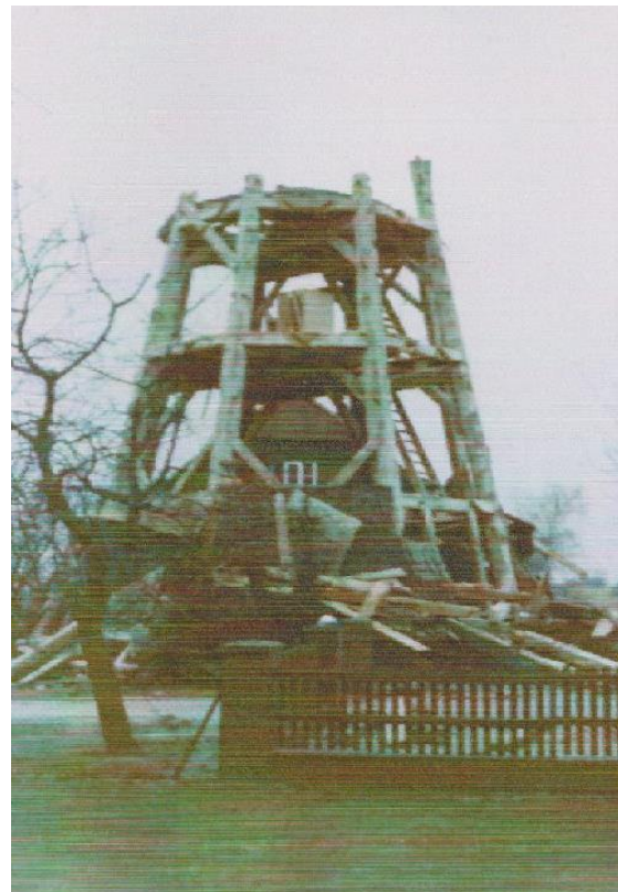
..., die Mühle ist entkernt ...
