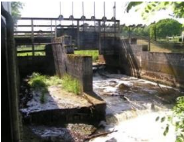
Das Wehr (von unten).
