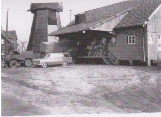
Das Rampenlager mit Unimog und Hänger, der gerade beladen wird sowie der Opel-Caravan, der dem Ausliefern kleinerer Mengen diente.
