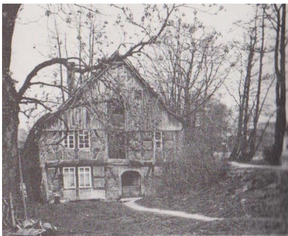
Die Mühle Mitte der 1960er Jahre auf einem alten Foto – rechts im Bild der Mühlendamm mit dem Zubringerweg auf der Dammkrone ...
