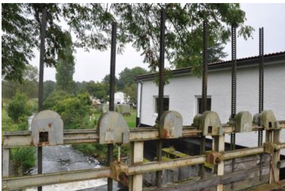
Das mit Zahnstangen betätigte Wehr diente zum Anstauen der Wietze.
