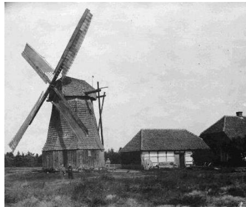
Wohn- und Wirtschaftsgebäude standen dicht neben der Windmühle.
