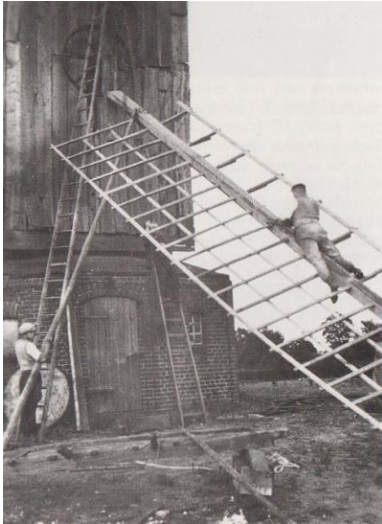
Die Flügel der Windmühle wurden oft in Eigenleistung gebaut und erneuert.
