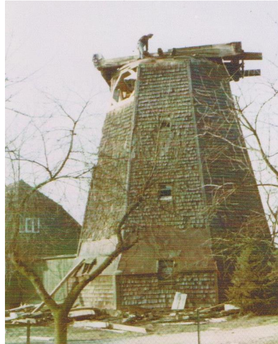
Der Abbruch beginnt ...
