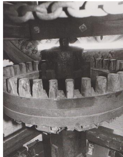
Verbliebene Reste der Antriebstechnik im Kopf der Mühle.
