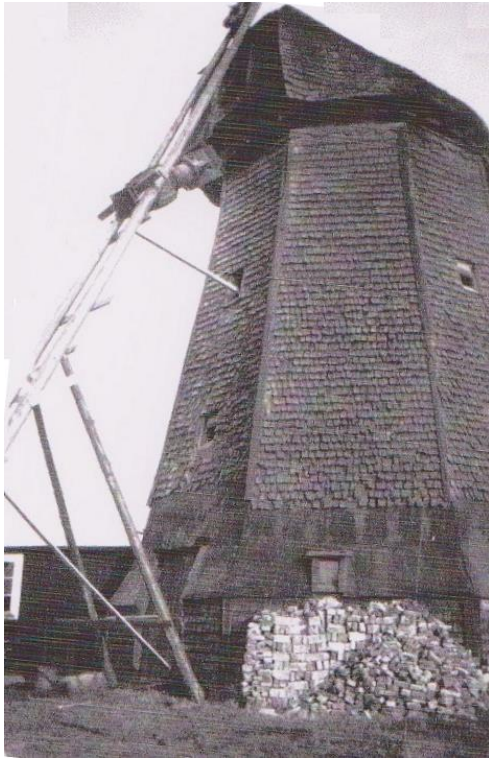
Der Flügelkopf wird ausgebaut.
