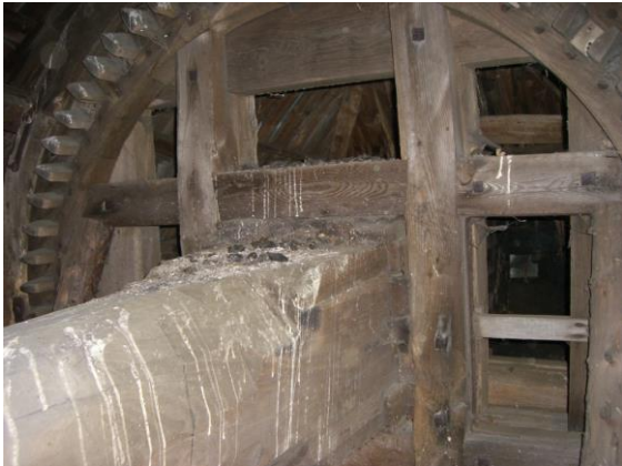
Die Flügelwelle und das Kammrad der Abbenser Windmühle befinden sich in einem (noch) guten Zustand.
