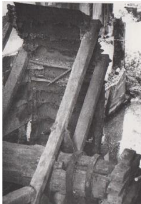
Das Wasserrad vorher ...
