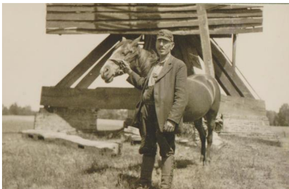
Der Mühlenbock stand erhöht auf dem gemauerten Fundament.
