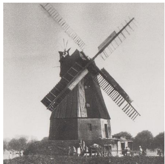
Die Mühle 1928 mit beachtlichen 120 qm Flügelfläche.
