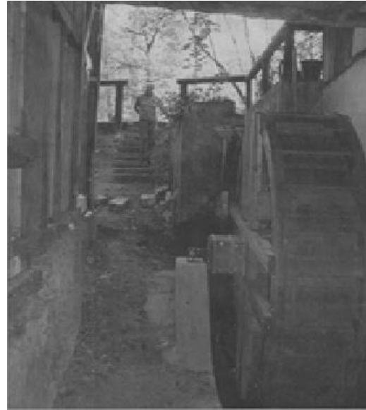
Mit diesem Bild von 2001, das Erich Martens die Treppe hinabgehend zeigt, gewinnt man einen Eindruck von der Größe des Wasserrades.
