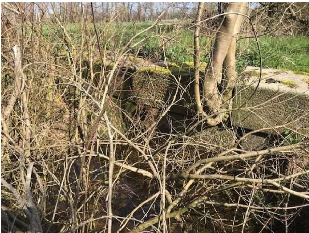
Brelingen, Befestigung eines Grabendurchlasses (Foto: Fritz Schröter)
