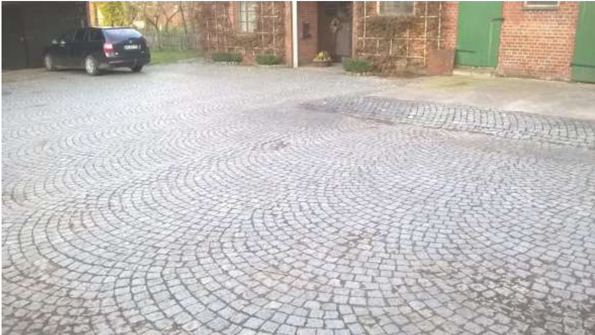
Granitpflaster auf einer Hofstelle in Brelingen (Foto: Oliver Bohm)
