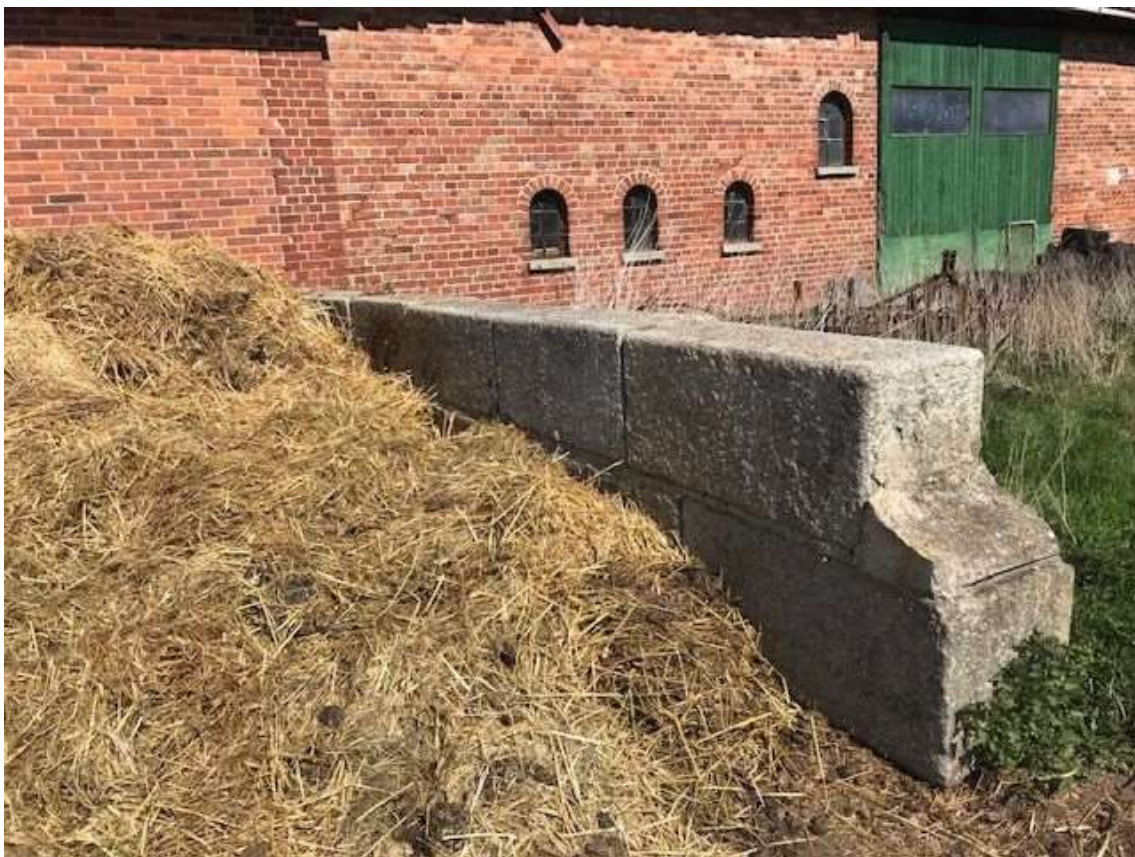
Brelingen, Seitenbegrenzung einer Mistplatte (Foto: Fritz Schröter)
